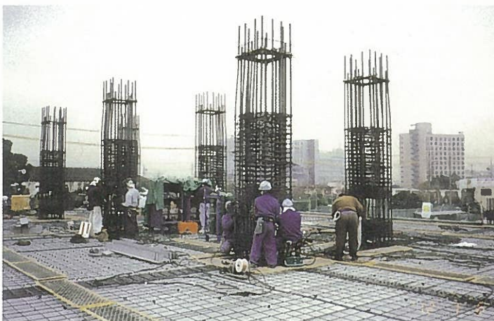
先組み工法（柱）
